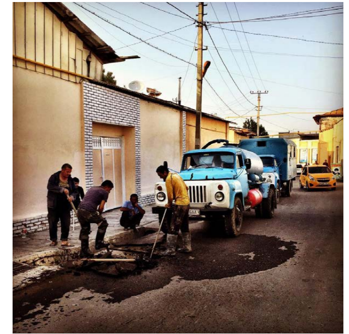
Strassenarbeiter in Samarkand
